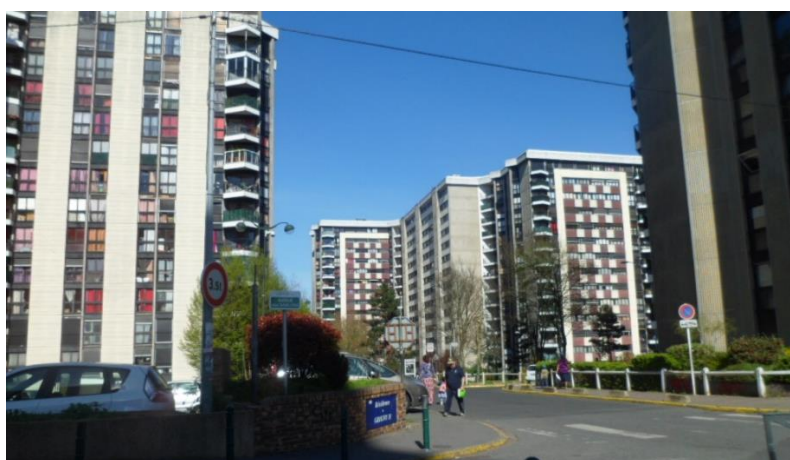
Figura 4: Conjunto Habitacional de Grigny 2 em Grigny/França. Foto tirada pela autora em 14 de abril de 2015.
