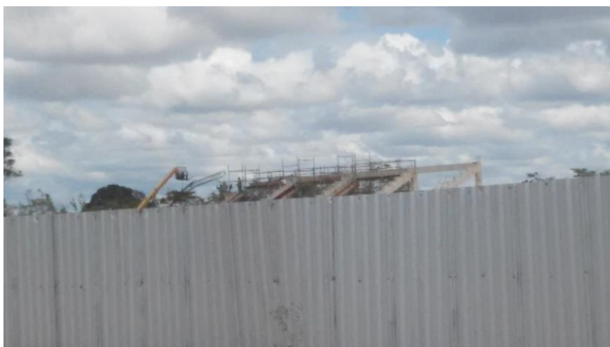
Figura 14: Outra arquibancada sendo construída - 2016
