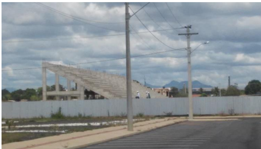
Figura 13: Arquibancada do estádio sendo construída - 2016
