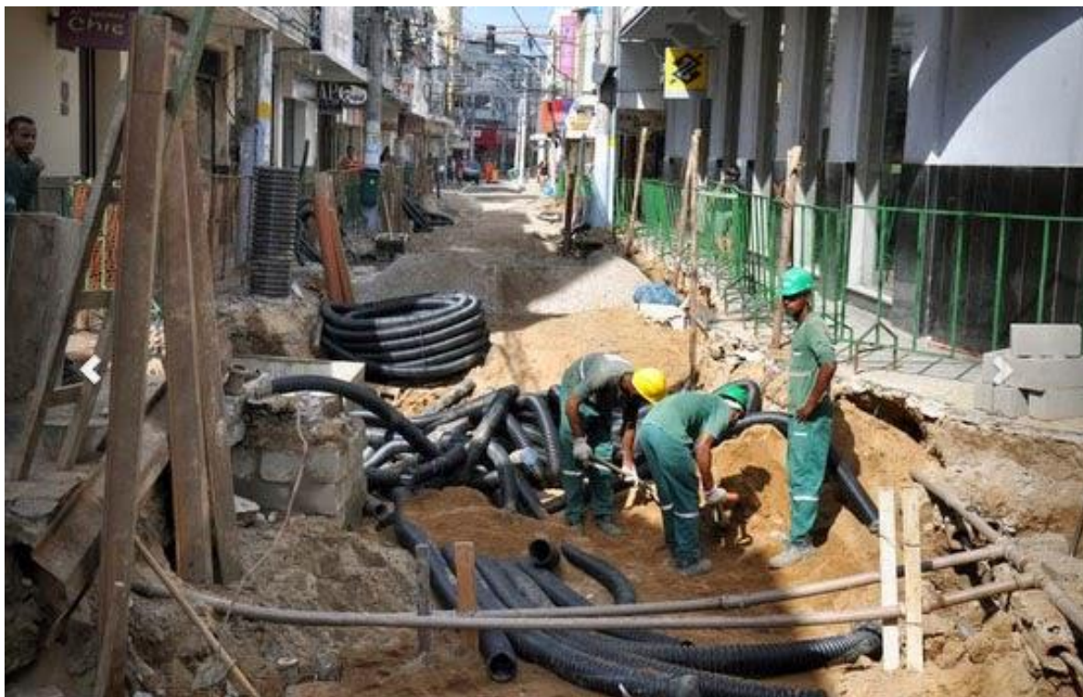
Figura 1 – Reforma em processo no Centro de Campos dos Goytacazes.
