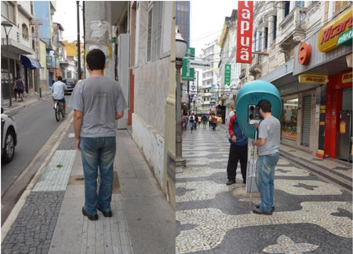
Figura 13 - Lázaro Gomes se deparando com o poste no meio do piso tátil e orelhão no meio da calçada - Trabalho de Campo realizado em 24 de outubro de 2017.
