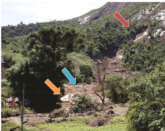
Figura 04: Demonstração Lateral do escorregamento (seta vermelha), de um grande bloco rolado (seta laranja) e do grande acúmulo de massa de solo em declive (seta azul) Fonte: Relatório do DRM-RJ 2011
