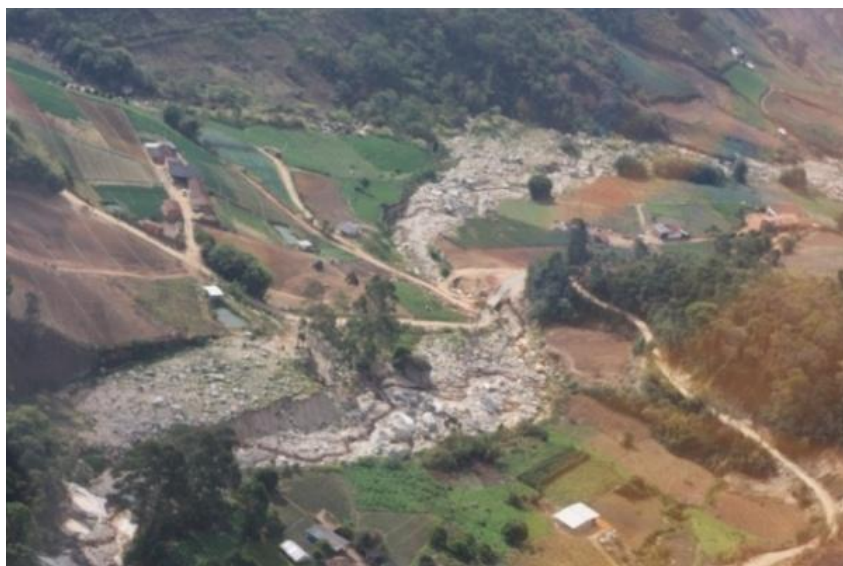
Figura 10: Leito do rio coberto por material depositado. Fonte : Relatório do DRM 2011.
