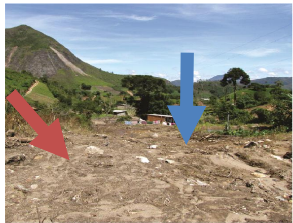
Figura 05: Demonstração da massa de solo instável (seta vermelha) e da residência no alcance (seta azul) de um provável reativamento da mesma. Fonte: Relatório do DRM-RJ 2011
