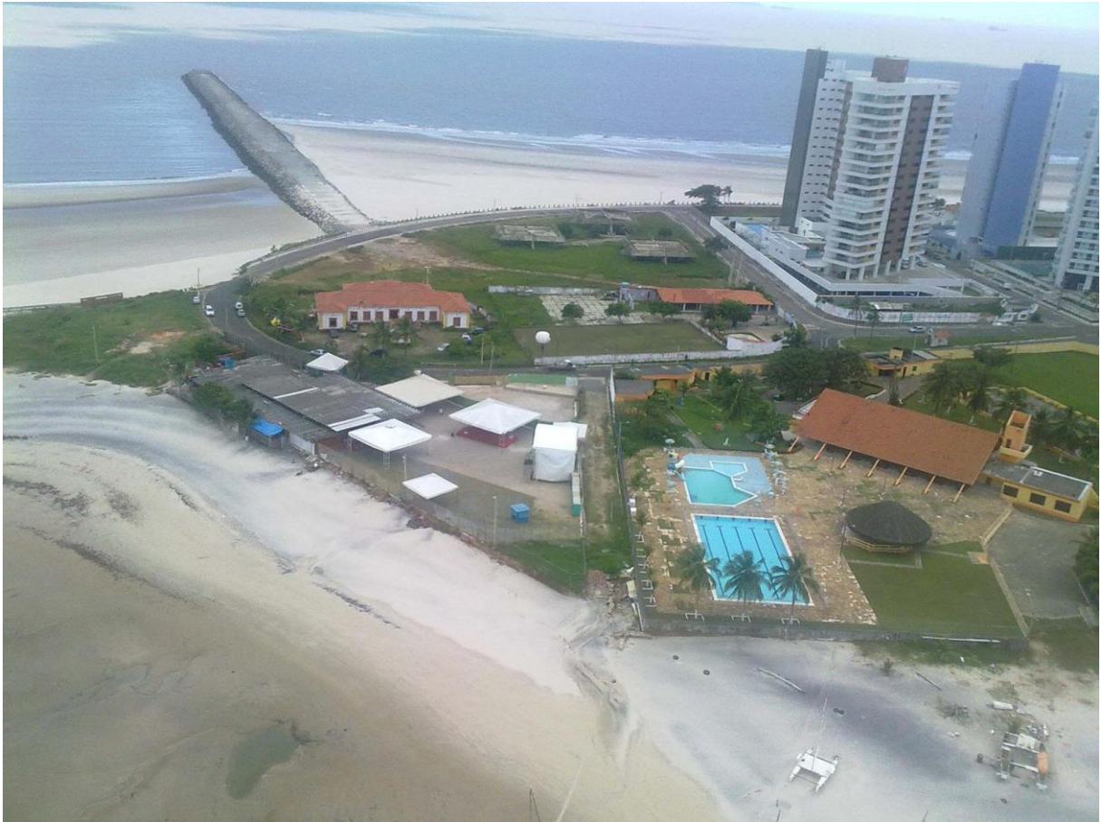
Figura 04 - Espigão Costeiro da Ponta d'Areia, construído pelo Governo do Estado em São Luís para conter o avanço da erosão na área e desassorear o canal. (Foto: Antônio Martins).
