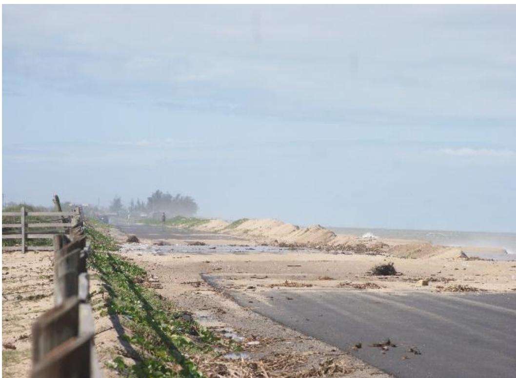
Figura 18 - Aspectos de erosão de praia e transposição de ondas de tempestade na Unidade III, Trecho 04. Foto -
