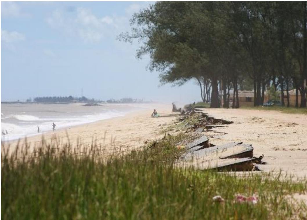
Figura 17 - Erosão Costeira no trecho. Foto - Eduardo Bulhões.
