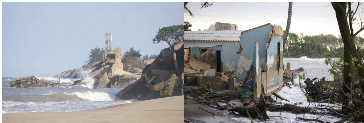
Figura 21. Erosão costeira na praia de Atafona, 2014. Foto: Eduardo Bulhões. Figura 22. Erosão Costeira no pontal de Atafona, 2016. Foto: Eduardo Bulhões.
