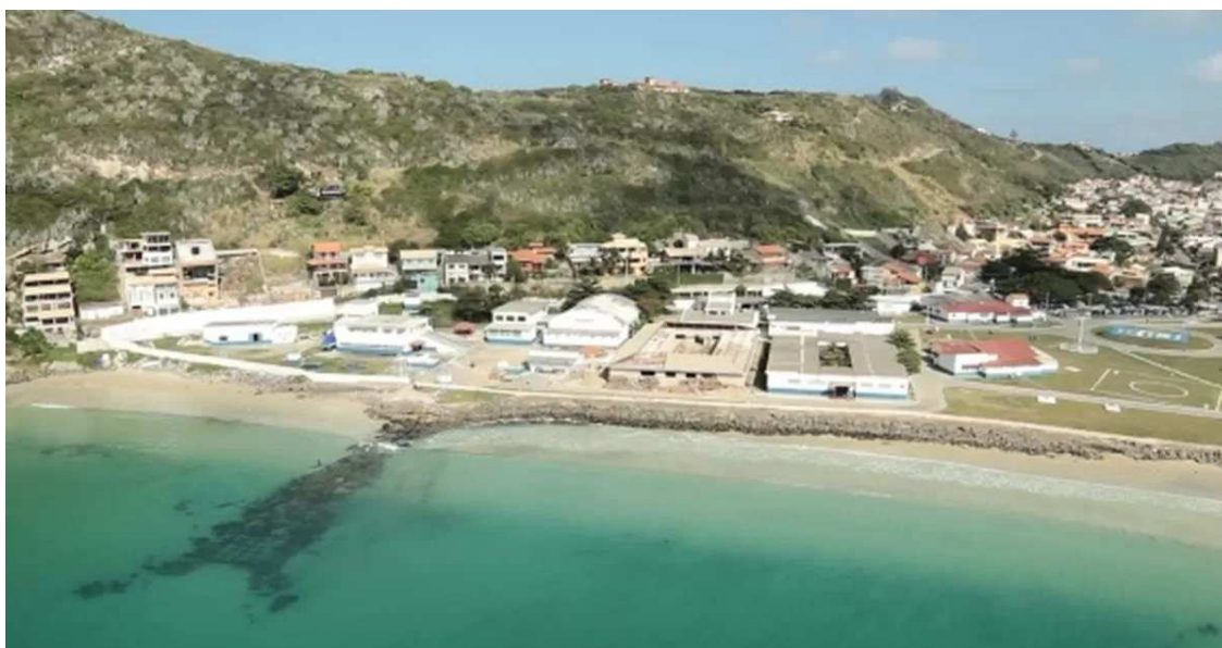
Figura 6. Vista aérea do IEAPM na praia dos Anjos em Arraiial do Cabo. Destaca-se segmento em erosão costeira protegido por obra longitudinal aderente de defesa do litoral do tipo enrocamento. Fonte: G1 Globo.
