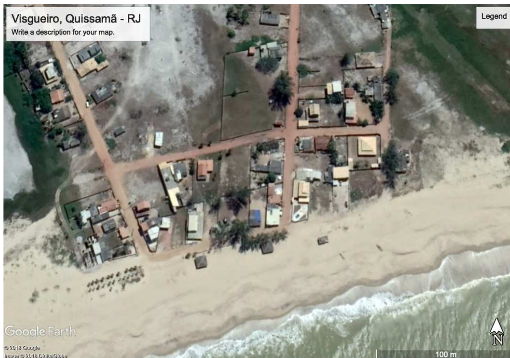
Figura 14. Comunidade de Visgueiro em Quissamã, RJ. Ocupação sobre a faixa de areia do perfil ativo da praia. Fonte: Imagens Google Earth.
