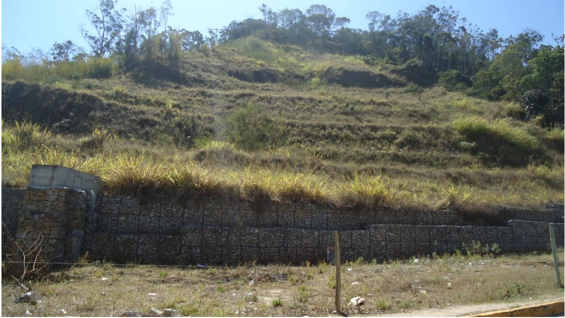
Figura 27: Bioengenharia nos local do deslizamento planar, Rua Cristina Ziede, Nova Friburgo
