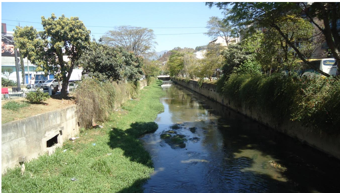
Figura 24: Assoreamento do rio São João Bengalas, Nova Friburgo, RJ
