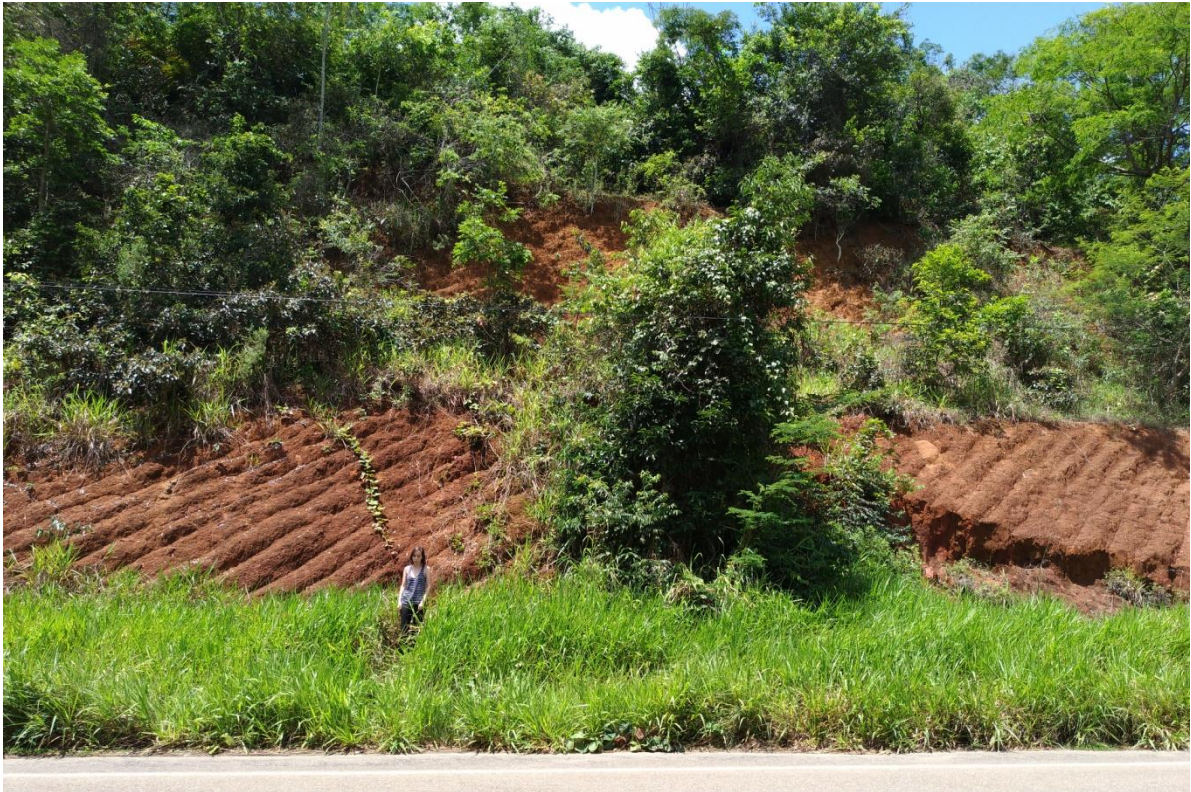
Figura 18 MIRA 02 com plano de falha encoberto por vegetação. Fonte: Arquivo do autor.
