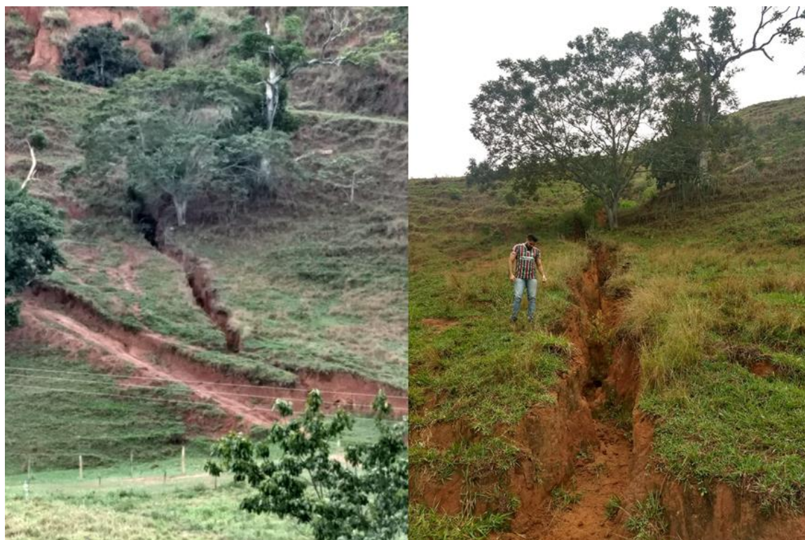
Figura 10. Voçoroca desconectada ativa desenvolvida na encosta lateral da cabeceira de drenagem. Fotografia tirada no dia 06 de julho de 2019.
