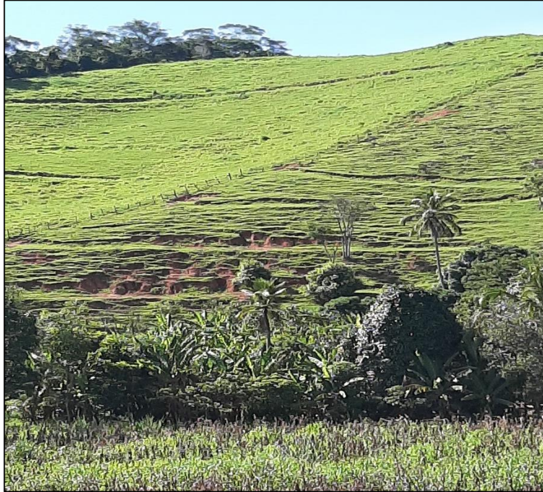
Figura 19: Manejo inadequado com solo desprotegido em encosta com processo erosivo acentuado e culturas à jusante na encosta
