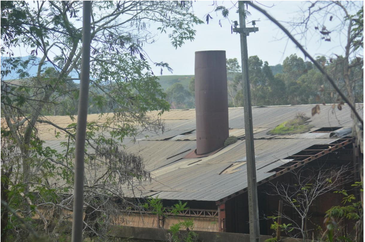
Figura 11: Telhado e atual chaminé da fábrica. (Elis Miranda, 2018 – Acervo Fotográfico do LabCult)
