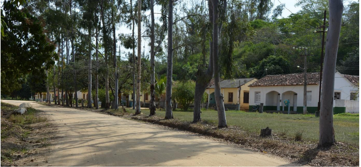
Figura 17: Vila dos trabalhadores da Usina Pureza. (Elis Miranda, 2018 – Acervo Fotográfico do LabCult)
