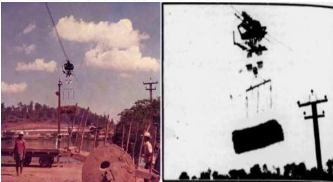
Figura 28: Montagem: Cabo aéreo em funcionamento durante a década de 1970 (Acervo pessoal de Sijam Frem e O Fluminense, 1977)
