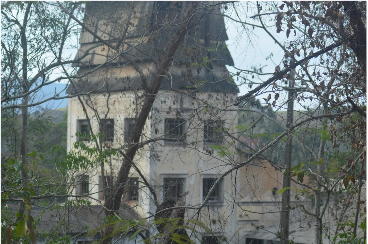
Figura 5: Prédio onde se localizava o escritório administrativo do Engenho. (Elis Miranda, 2018 – Acervo Fotográfico do LabCult.)
