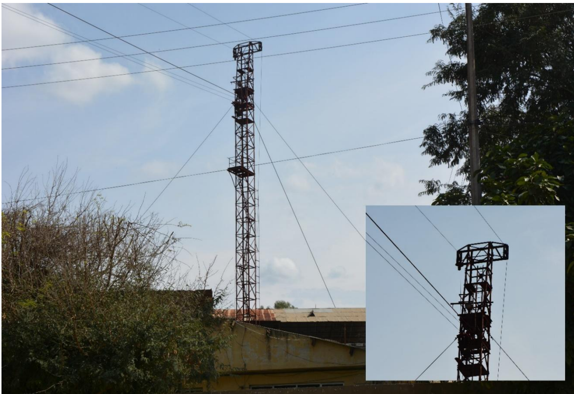
Figura 27: Guindaste e cabos de aço na Usina Pureza. (Elis Miranda, 2018 – Acervo Fotográfico do LabCult)
